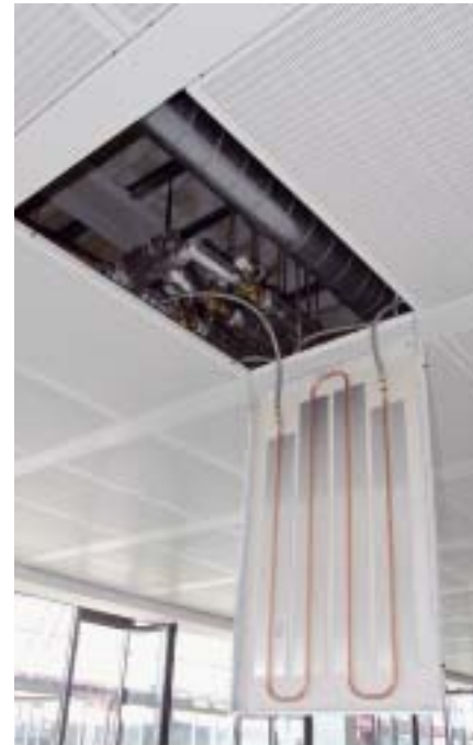
Wird eine Metalldecke zum Heizen und Kühlen genutzt, muss die Möglichkeit zur Revision gegeben sein.
